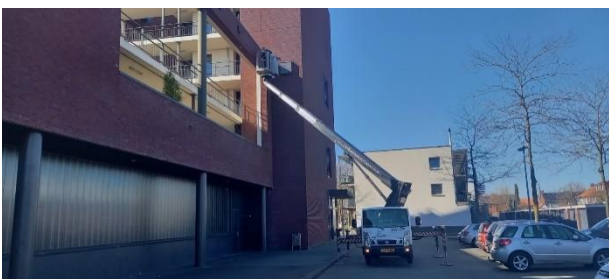
Nestkasten worden geplaatst in de omgeving van de te slopen woningen
